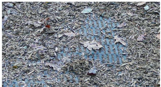
Rasenschutzmatte in eingebautem Zustand (für Foto freigelegt)
