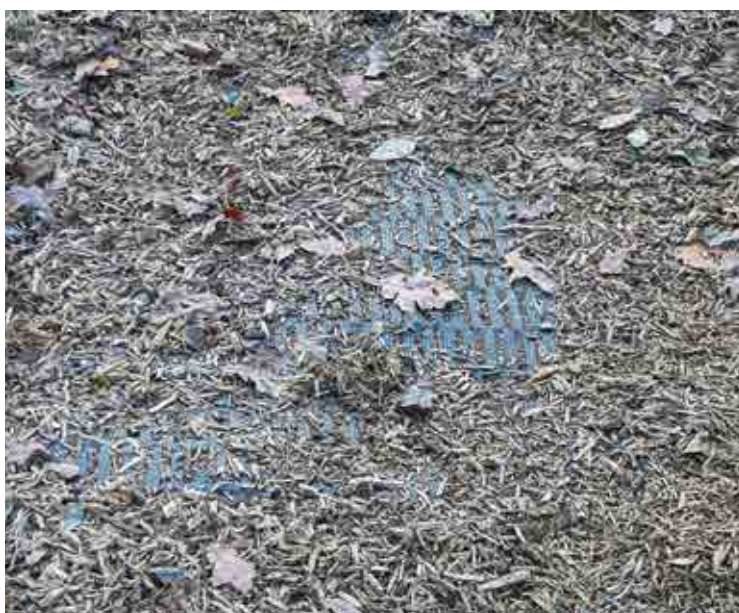
Rasenschutzmatte in eingebautem Zustand (für Foto freigelegt)
