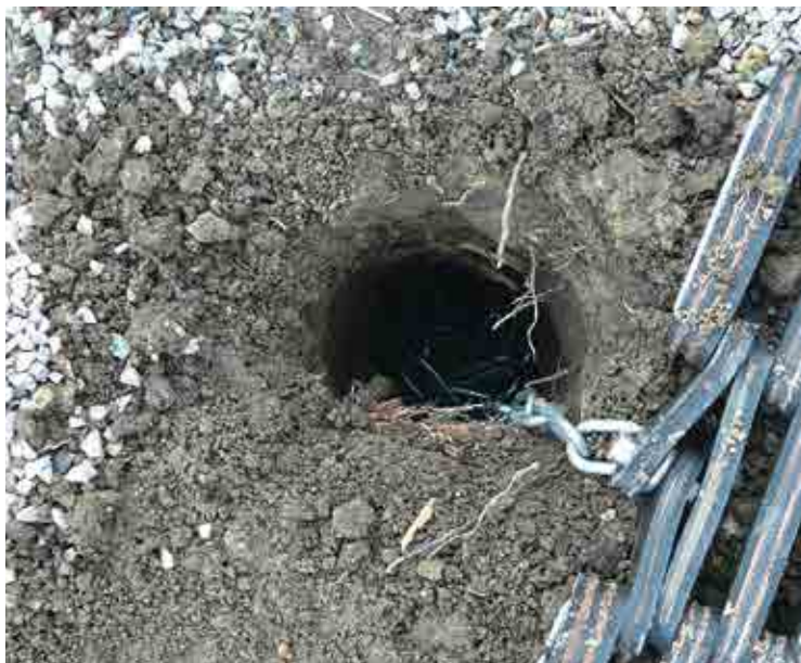
Kleines Erdloch für Ankerketten + Punktfundament (ca. Ø 5,00 cm)
